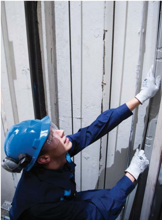
KONEen ammattilaiset varmistavat laitteiden luotettavan ja nopean asennuksen.
