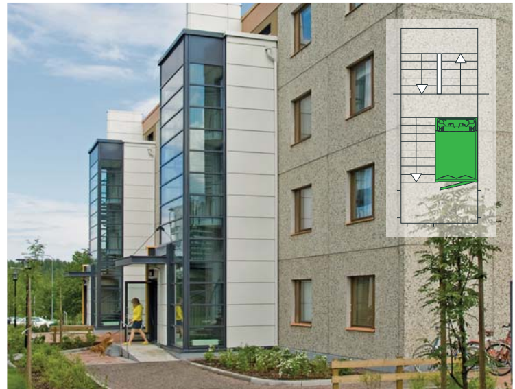
Hissi toisen portaan tilalla ja uusi porrastorni talon ulkoseinällä
