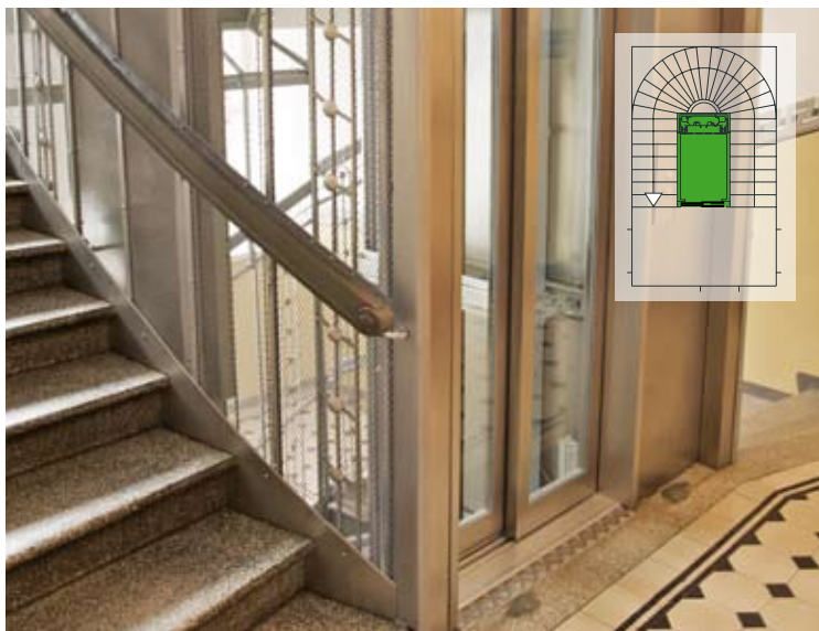
Dentro del hueco de una escalera de caracol
