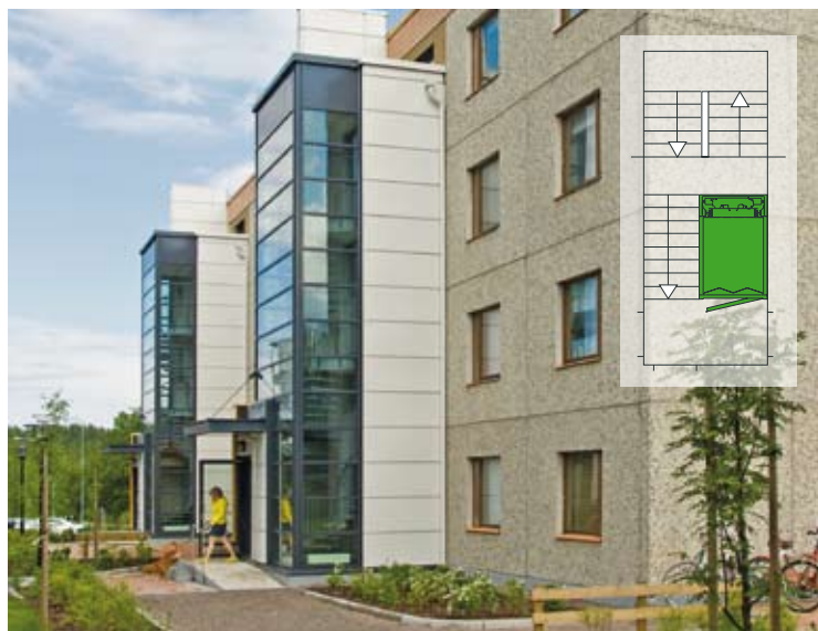
El ascensor se instala en un tramo de la escalera, el tramo suprimido se ubica en el exterior del edificio.
